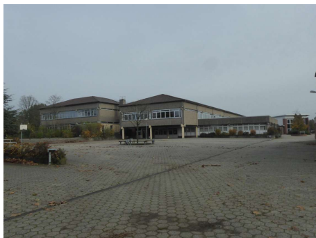
Schulgebäude Blickrichtung Osten
