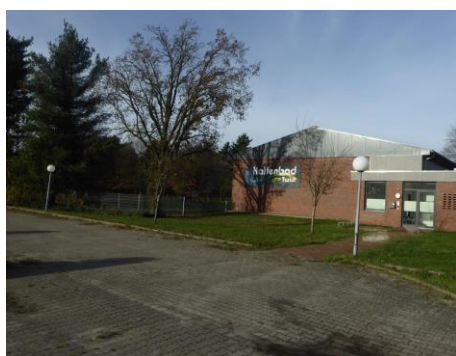
Hallenbad Blickrichtung Norden
