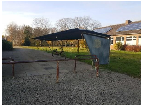
Radabstellanlage an der Turnhalle
