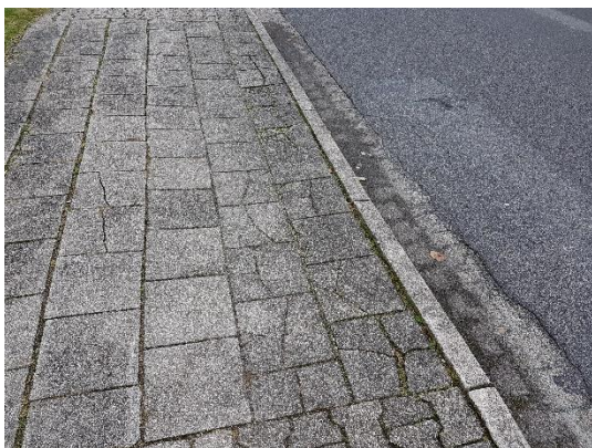
Gebrochene Steine im Fußweg
