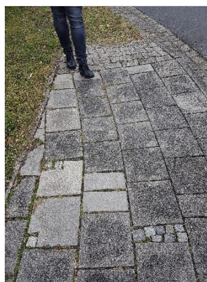
Aufgefüllte Löcher im Fußweg
