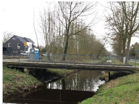
Brücke Georg-Klasmann-Straße/An der Wieke
