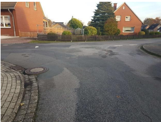
Risse und Unebenheiten in der Fahrbahn
