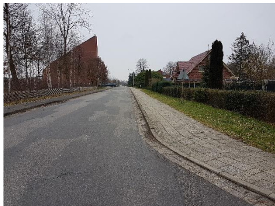
Stückhafte Nachbesserung des Fahrbahnbelags
