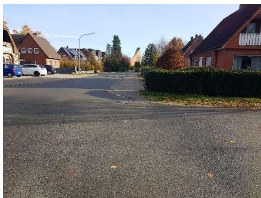
Abgesenkter Bordstein im Kreuzungsbereich
