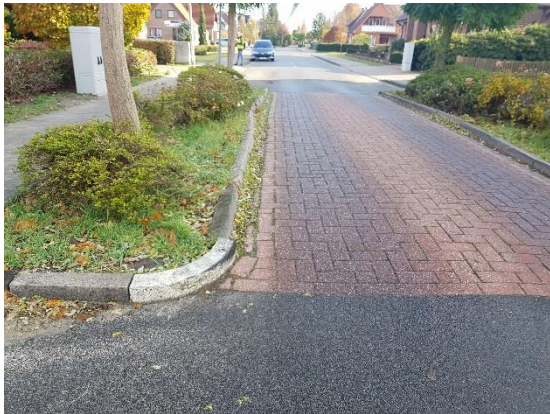
Abgesackter Bordstein in der Ansgarstraße
