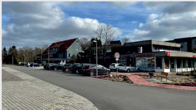
Die Arbeiten der Straße „An der Apotheke“ sind abgeschlossen. Mit der Anbindung der Straße „Am Kanal“ wurde gleichzeitig die Straßenentwässerung, der öffentliche Parkraum, eine neue Straßenausleuchtung sowie der Gehweg, der von den öffentlichen Parkplätzen verläuft und somit die Gefahr einer Kollision von ausparkenden Fahrzeugen und Fußgängern verhindert, erneuert.
