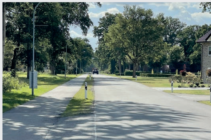
Die neue Ortsdurchfahrt in Hebelermoor mit separatem Radweg und begrüntem Mittelstreifen sorgt für mehr Sicherheit und ein attraktiveres Ortsbild.
