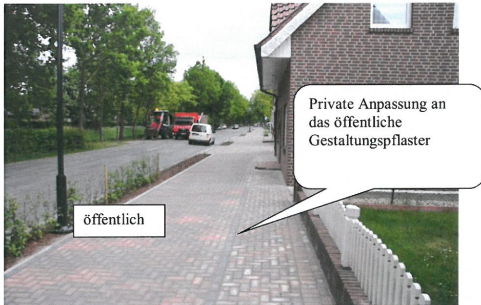
Beispiel: Private Anpassungsmaßnahmen (außerhalb DE-Förderung)
