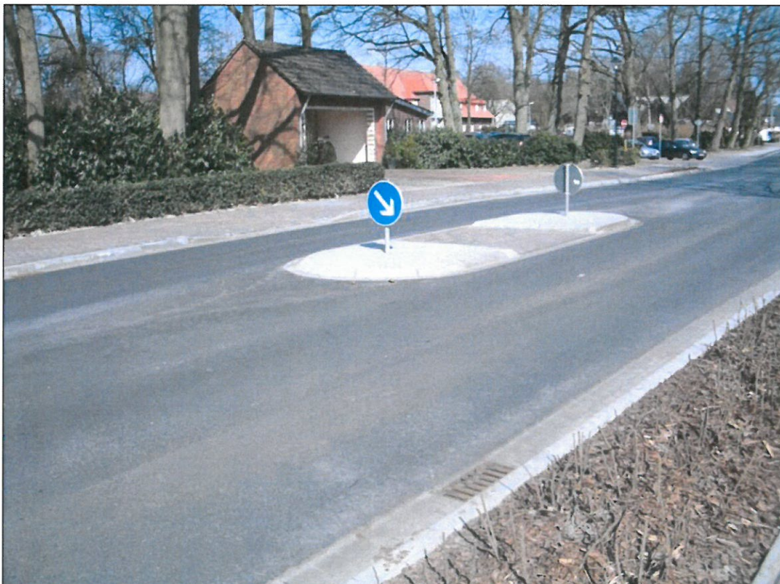
Foto Fahrbahnteiler mit Querungshilfe Höhe Franziskuskirche – Brücke Provinzialstraße
