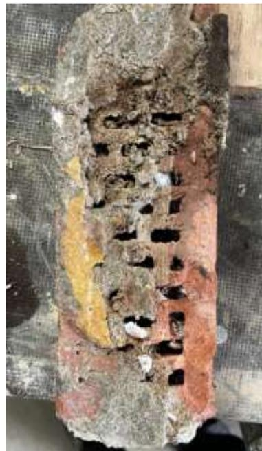
Daher musste im Rahmen eines Nachtrags die Erstellung eines neuen Sockels beauftragt werden. Auch das Betonfundament soll um etwa 30 cm erhöht werden, damit der Sockel nicht im Erdboden steht. Dabei soll für den neuen Sockel das Originalmaß von 53,5 cm x 59,5 cm berücksichtigt werden. Diese Maßnahmen wurden vorab mit der Denkmalschutzbehörde des Landkreises Emsland abgestimmt.
